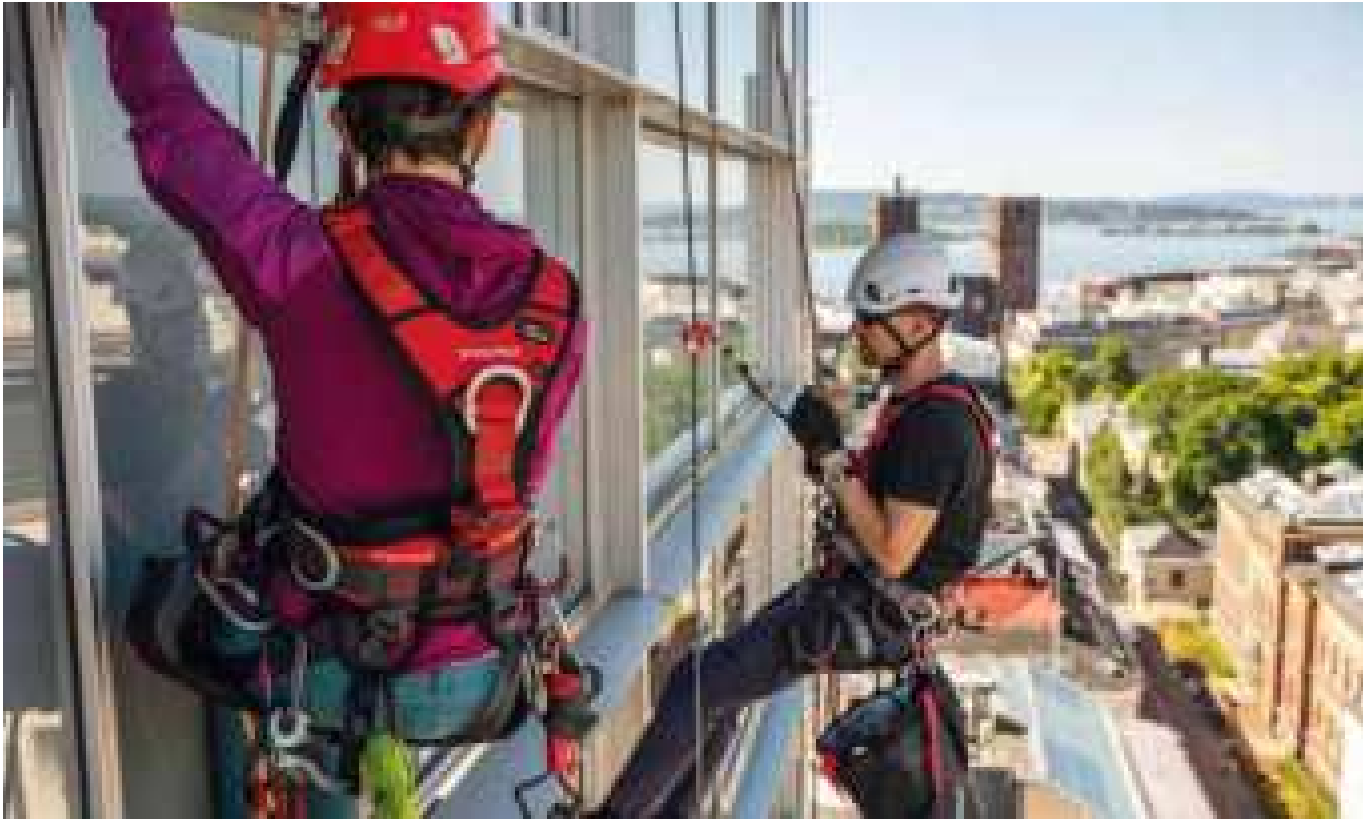
Philippa Betts and Torbjørn Solheim take in the view during rope access maintenance operations on a building facade. Las cuerdas dan a Philippa Betts y Torbjørn Solheim acceso a la fachada de un edificio para realizar operaciones de mantenimiento. Universitetsgata 2, Oslo, Norway (courtesy of Varri AS, ph.Kyrre Buxrud).
